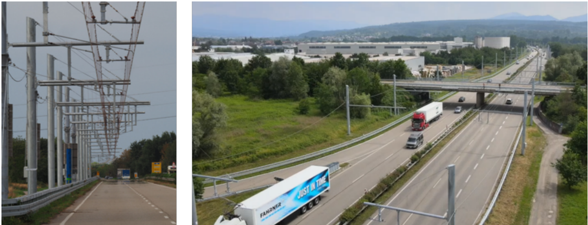
Abbildung 11: Visualisierung der ERS-Infrastruktur an der B462 in Deutschland
